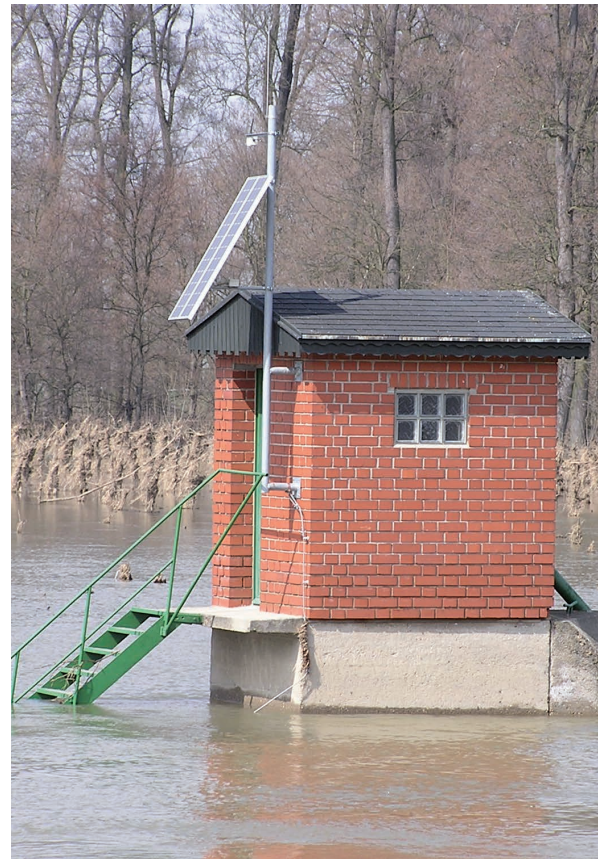
Pegelhaus Hohenau © viadonau
