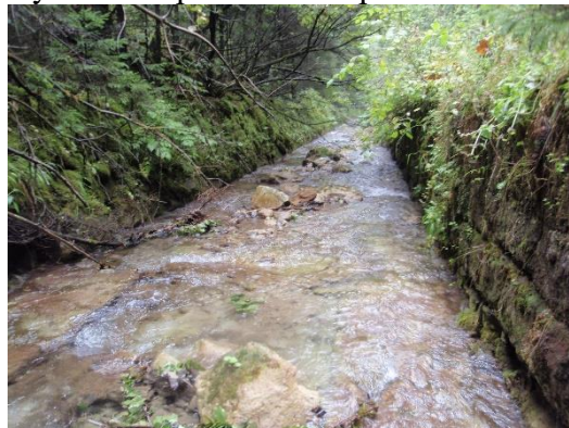
Bystrica – úprava toku v piatom úseku
