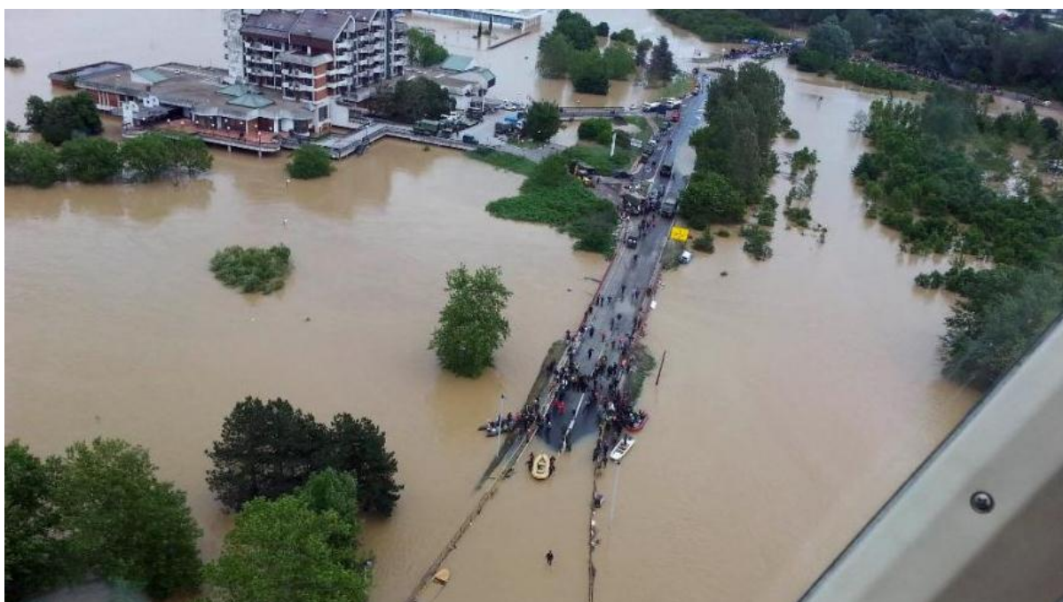
Obr.8 Zaplavené mesto Obrenovac
