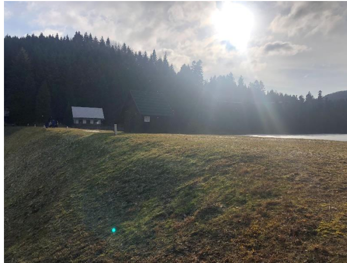
Obrázok 1: Vodná stavba Rozgrund (foto Koval', F.).
