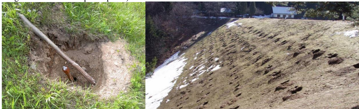
Obrázok 3: Stabilizácia vzdušného svahu Rozgrund zemnými klincami v roku 2006 s detailom zemného klinca (foto VV)
