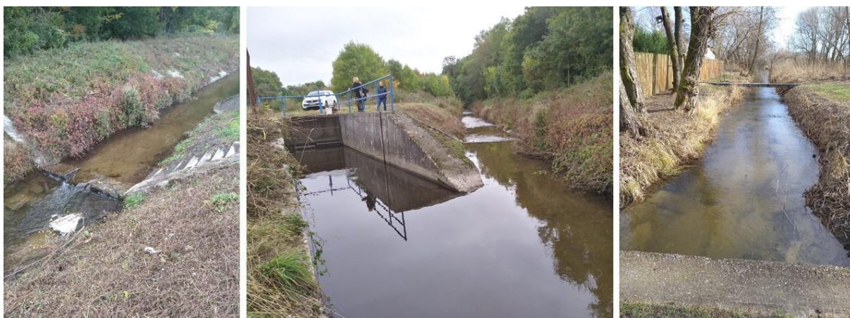
Obrázok 4. Prah pod odberom do nádrže Budmerice, odberný objekt a prívodný kanál
