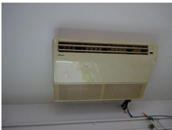
Obrázok 12 – Podstropná klimatizačná jednotka
