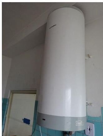
Obrázok 10 – Elektrický zásobníkový ohrievač
