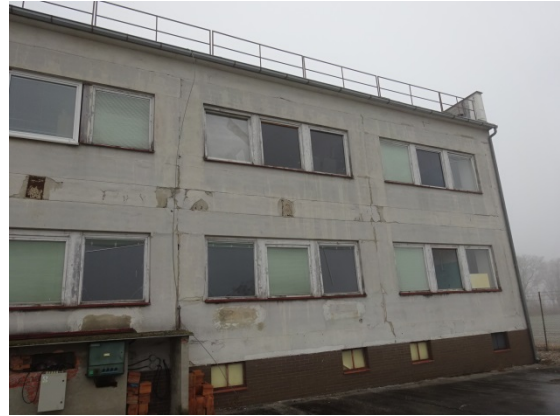
Obrázok 8 - Budova meteorologickej stanice Jaslovské Bohunice- vonkajší obvodový plášť
