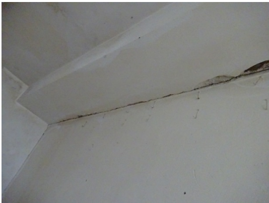
Obrázok 3 – Budova meteorologickej stanice Jaslovské Bohunice - detail statickej poruchy
