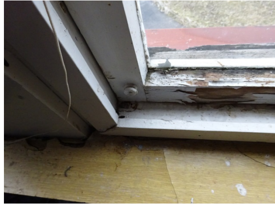
Obrázok 2 - Budova meteorologickej stanice Jaslovské Bohunice – súčasný stav otvorových konštrukcií
