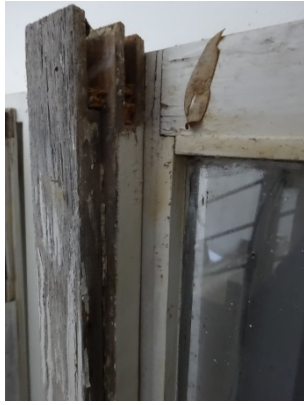
Obrázok 1 – Budova meteorologickej stanice Jaslovské Bohunice -Detail vymeneného okna
