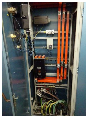
Obrázok 19 – Hlavný istič objektu
