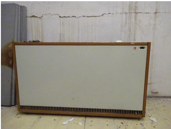
Obrázok 4 – Elektrické akumulčné kachle suterén
