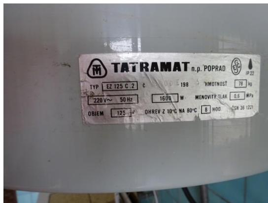
Obrázok 11 – Štítkový údaj zariadenia zásobníka
