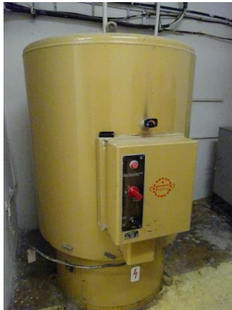
Obrázok 8 – Elektrický zásobníkový ohrievač
