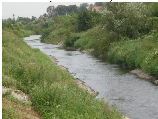
Roňava – koryto nad odberovým miestom
