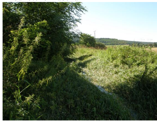
Malokozmálovský p – koryto v hodnotenom úseku
