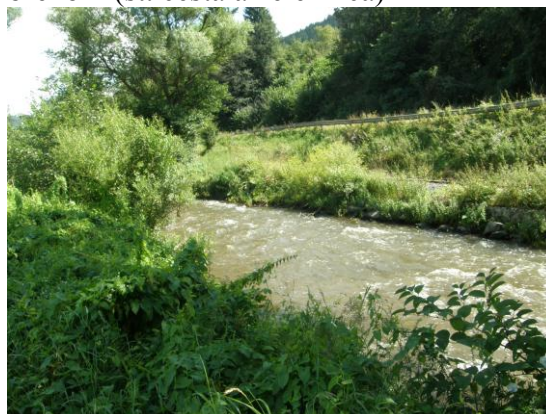
Čierny Hron – tok s opevneným ľavým brehom (št. cesta a železnica)
