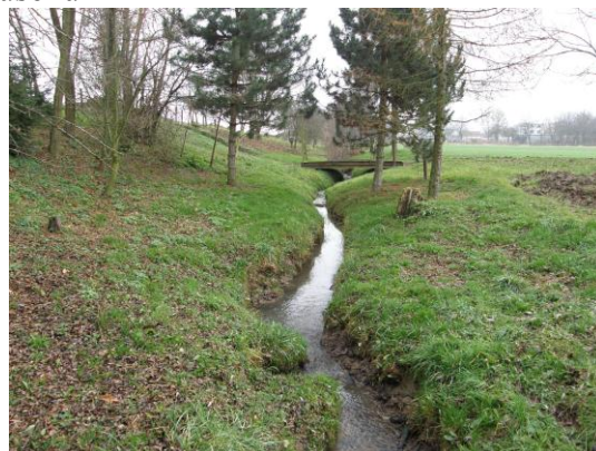
Dubovský p – koryto toku na hodnotenom úseku
