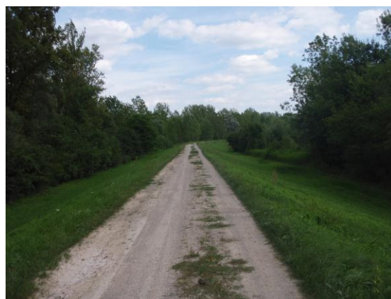
Latorica – ľavostranná odsadená hrádza
