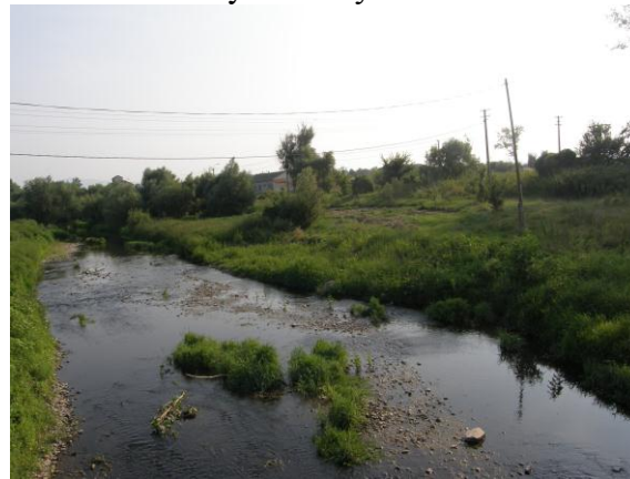
Kamenec – koryto a ľavý breh toku
