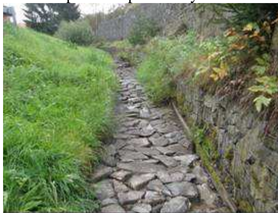
Šlahorov potok – úprava koryta
