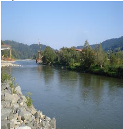
Poprad – mostná konštrukcia v toku
