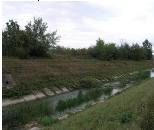
Turňa – opevnenie brehov
