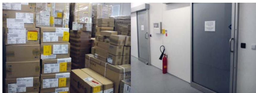
Obr. 5 Hardvér a ďalšie komponenty na výmenu celej infraštruktúry na všetkých pracoviskách SHMÚ. Nová výpočtová sála.
