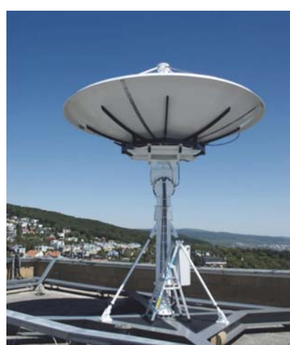
Obr. 4 Parabola na príjem údajov z cirkumpolárnych družíc. Je umiestnená na budove SHMÚ v Bratislave.
