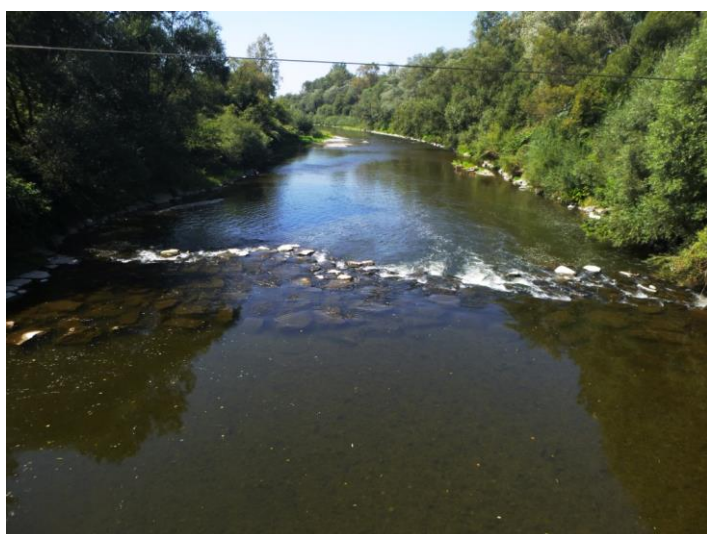
Obr. 9 Balvanitý sklz pri obci Špičky, pod ním v diaľke na ľavom brehu lavica (Janečková, 2017)
