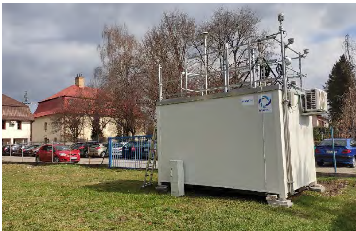
Pohľad na stanicu
