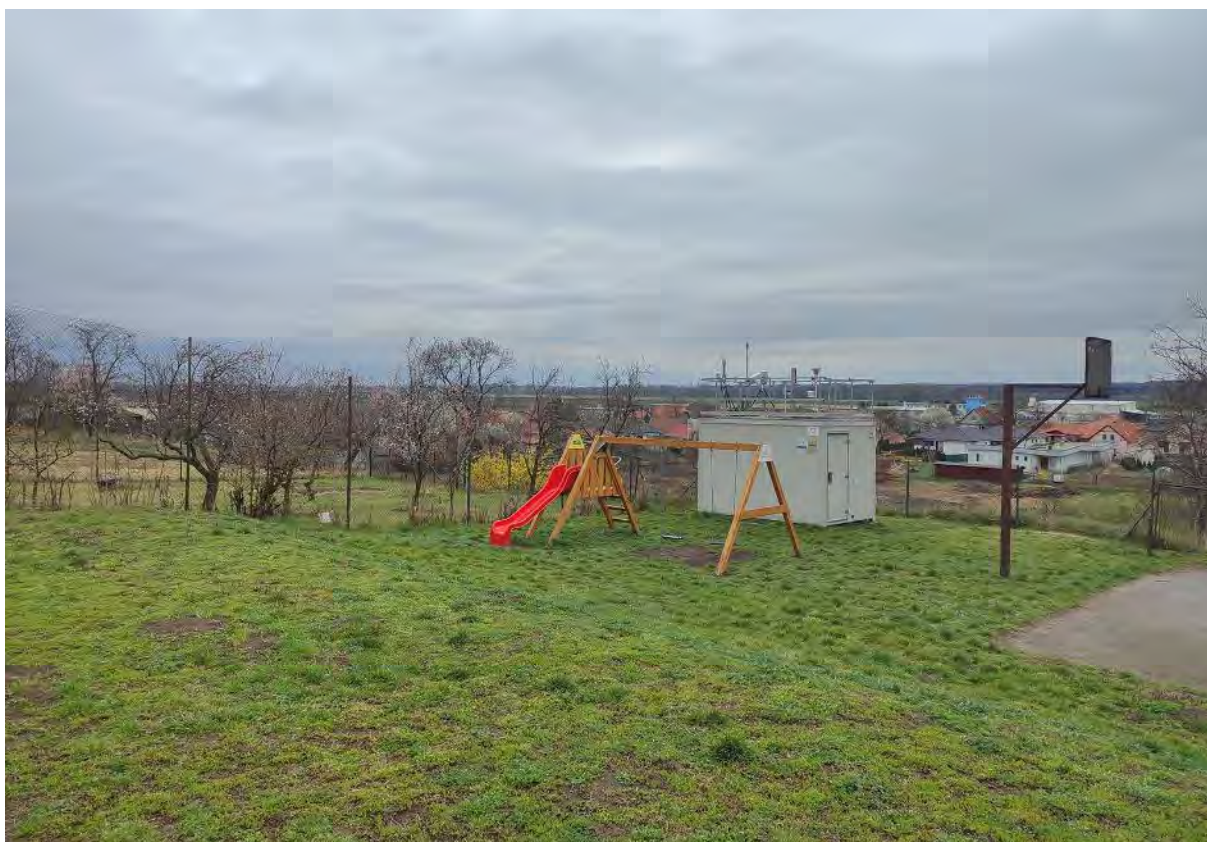
Pohľad na stanicu
