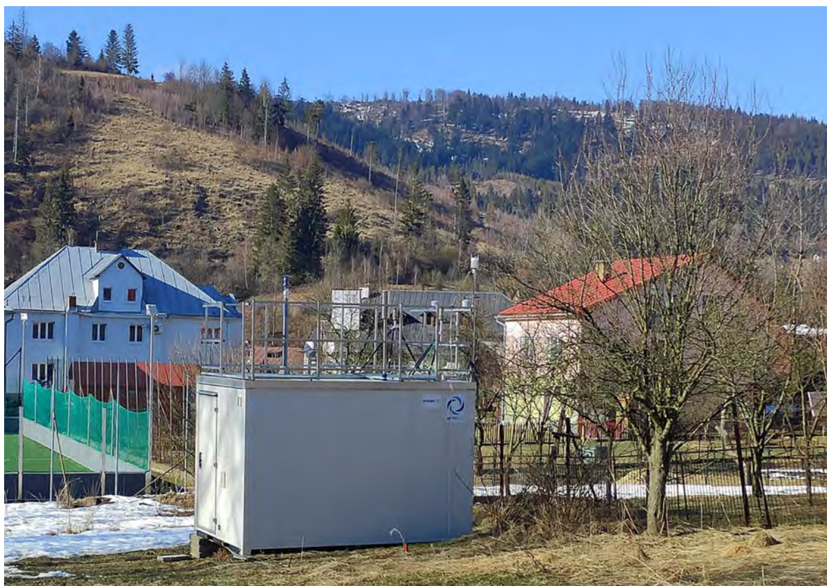
Pohľad na stanicu
