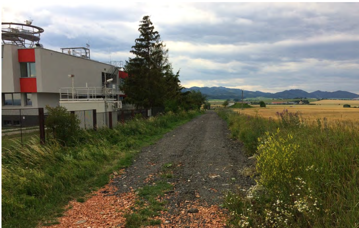
Pohľad na stanicu
