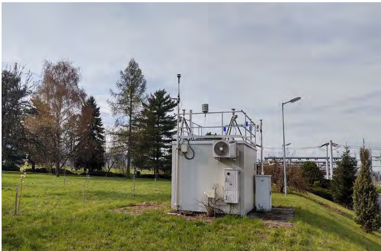
Pohľad na stanicu
