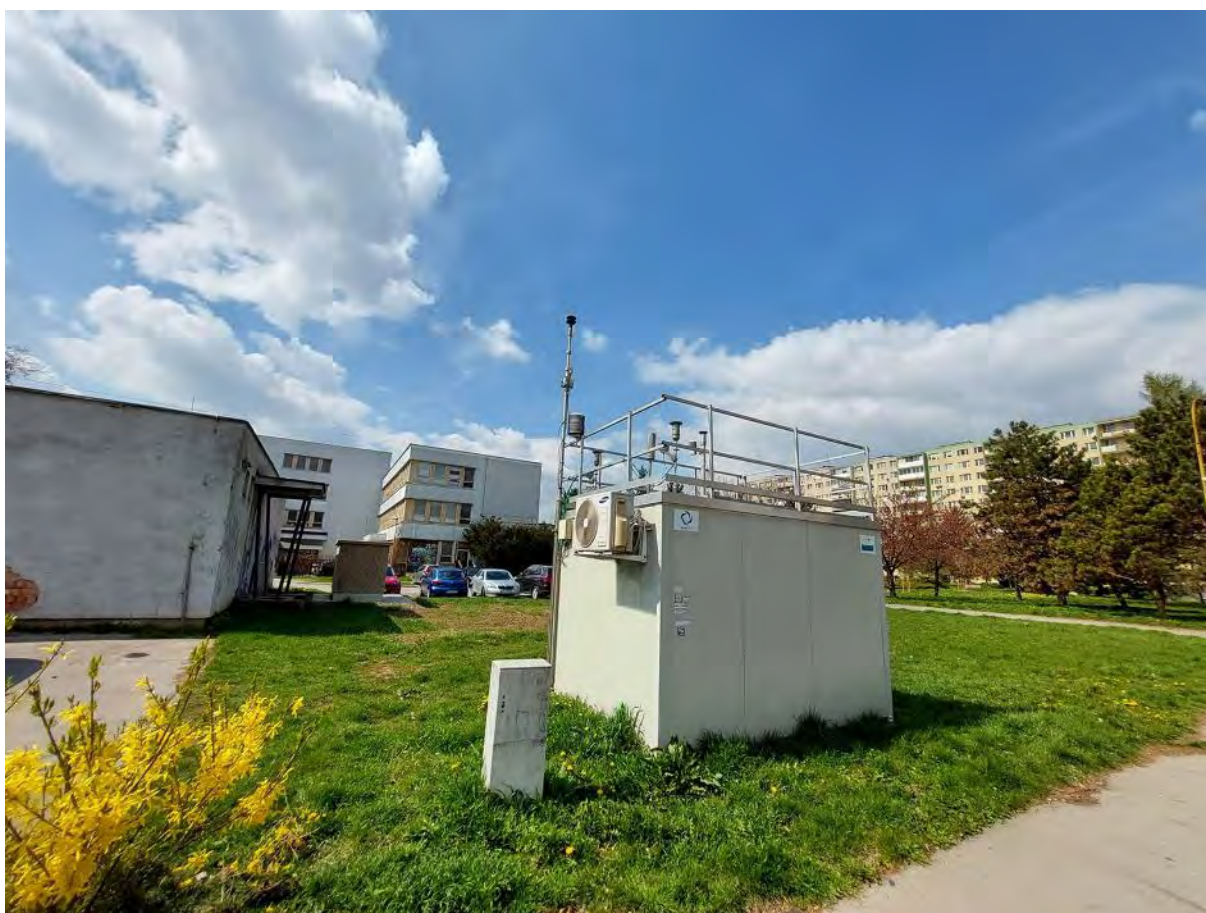
Pohľad na stanicu
