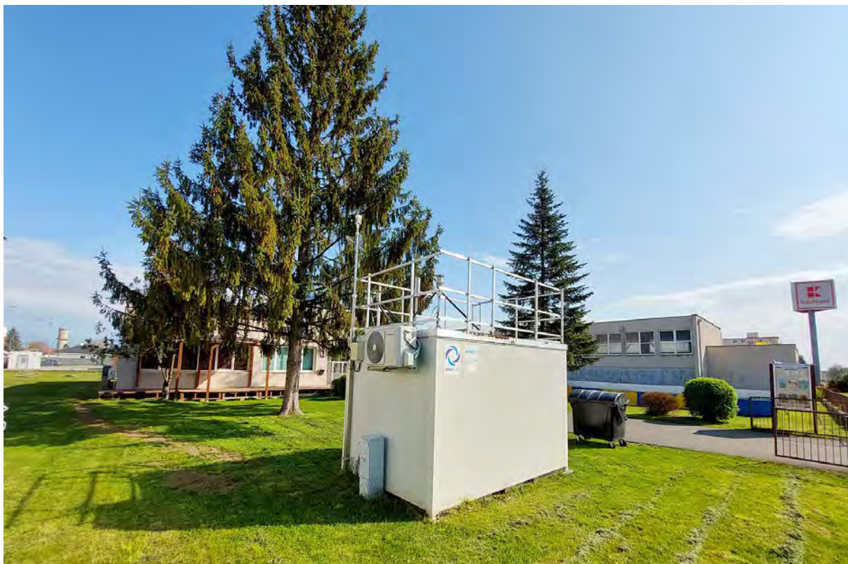
Pohľad na stanicu
