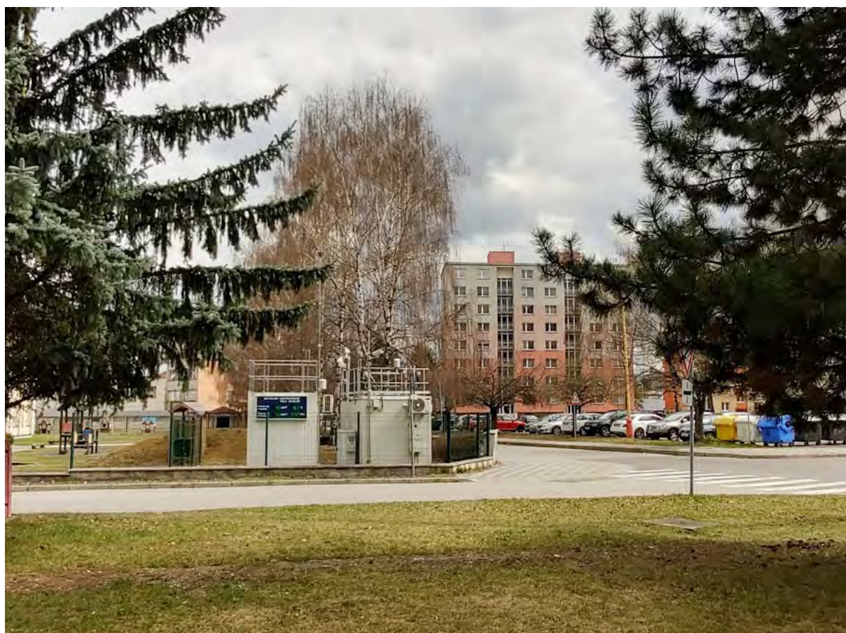
Pohľad na stanicu
