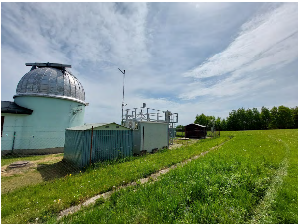
Pohľad na stanicu
