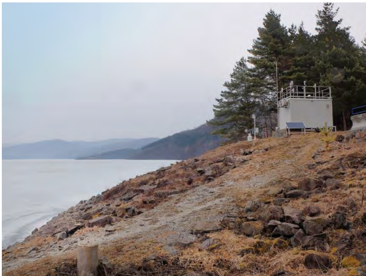
Pohľad na stanicu
