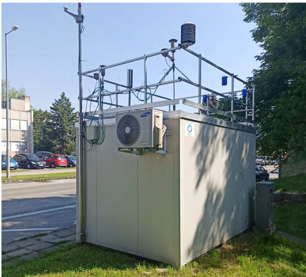
Pohľad na stanicu
