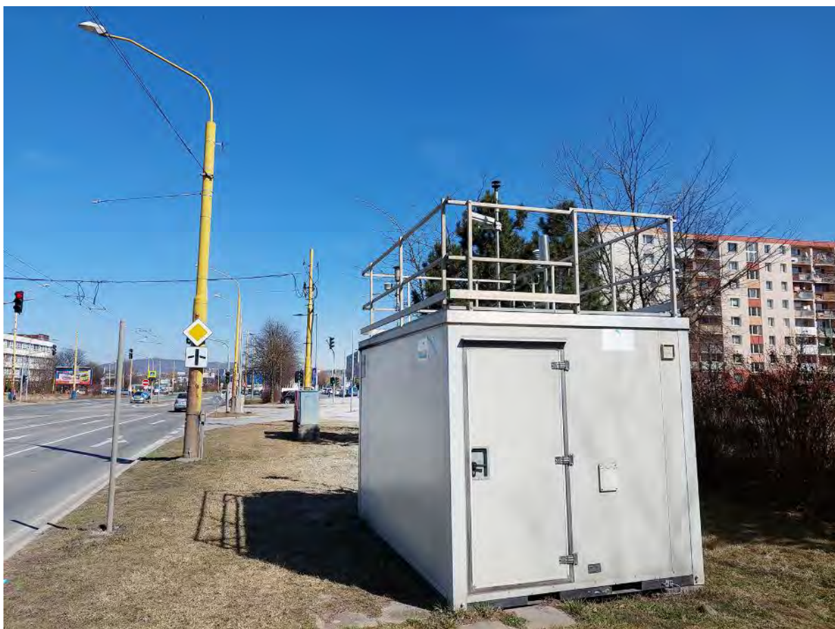
Pohľad na stanicu
