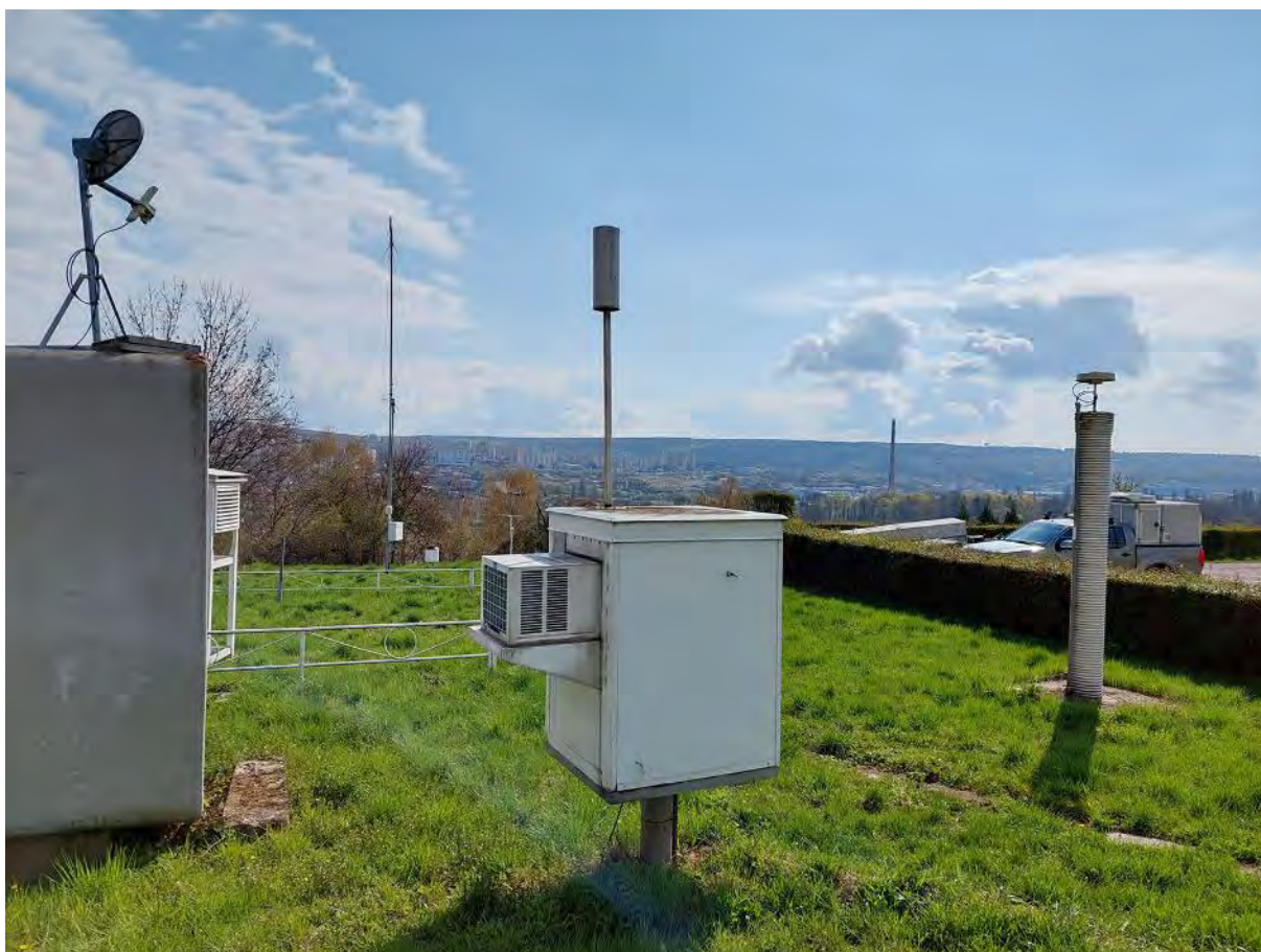
Pohľad na stanicu
