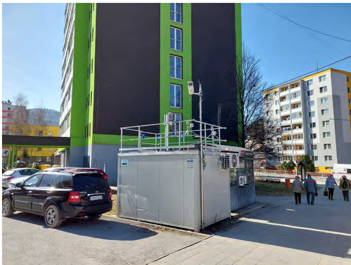
Pohľad na stanicu
