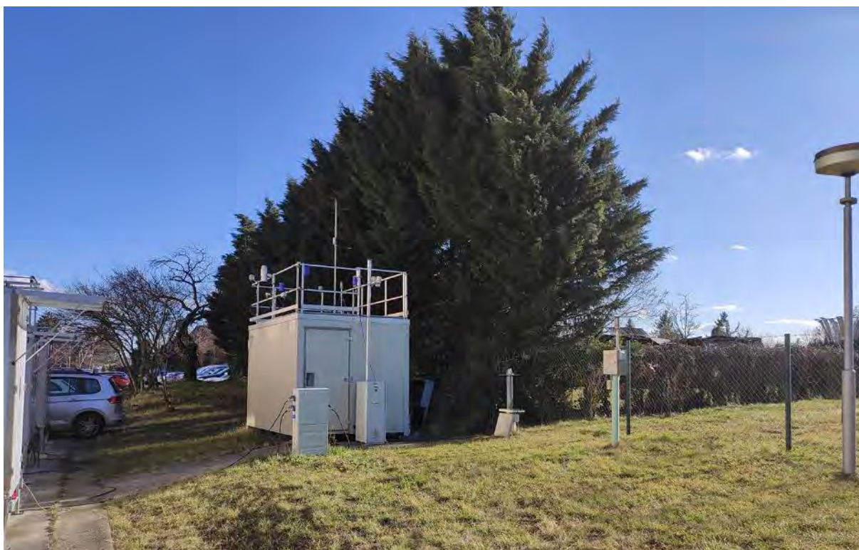
Pohľad na stanicu
