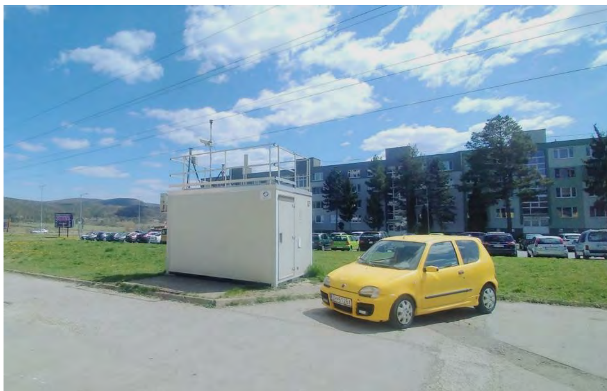
Pohľad na stanicu
